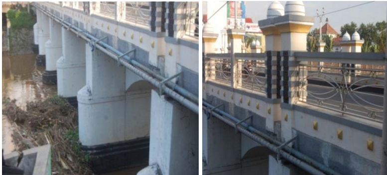
Foto4: Jembatan Kaligelis sebagai batas wilayah Kudus Kulon dan Kudus Wetan
