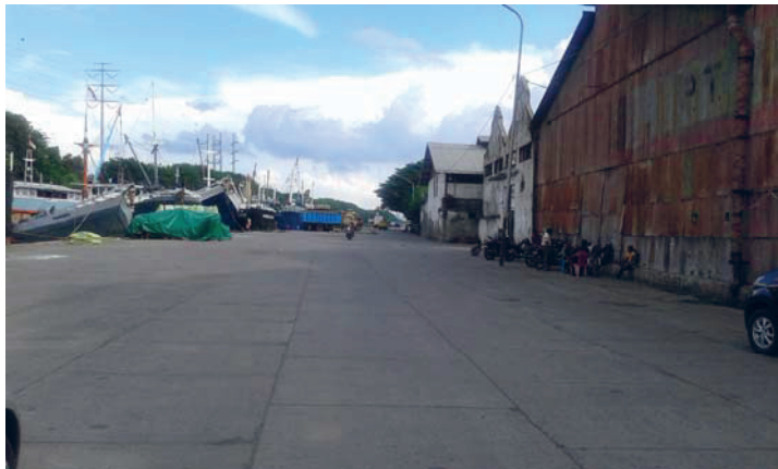
Foto 14: Deretan gudang di sepanjang Kalimas Sumber Koleksi Tim Peneliti
